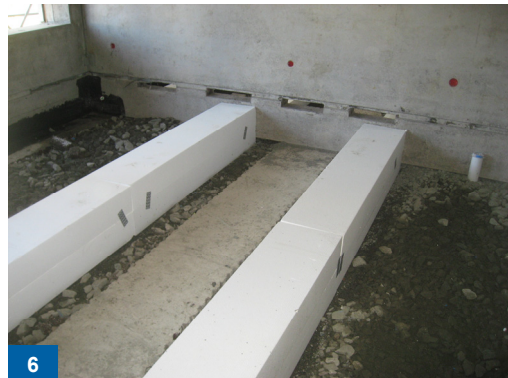
Lock fästes med spikplåt
