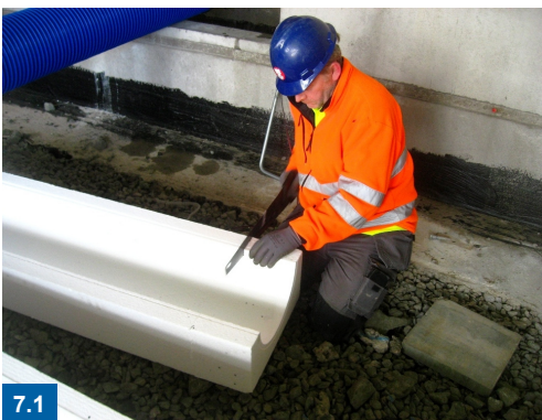
Längdanpassning med fogsvans
