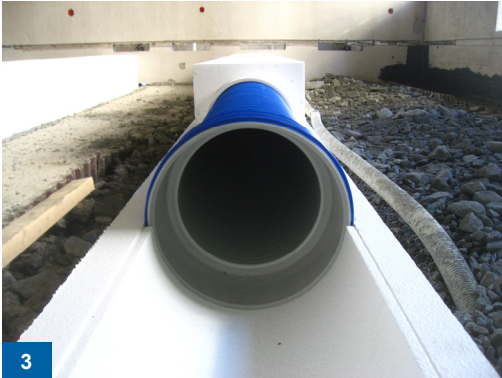
Mät muffens placering och kapa insats
